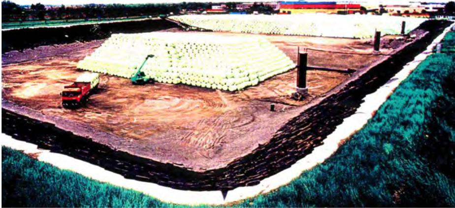
Los residuos que no se pueden recuperar son depositados en el **RELLENO SANITARIO**, un método de ingeniería para la disposición de residuos sólidos en el suelo de manera que se le dé protección al ambiente, mediante el esparcido de los residuos en pequeñas capas, compactándolos al menor volumen práctico y cubriéndolos con suelo al fin de día de trabajo, previendo los efectos adversos al ambiente.
